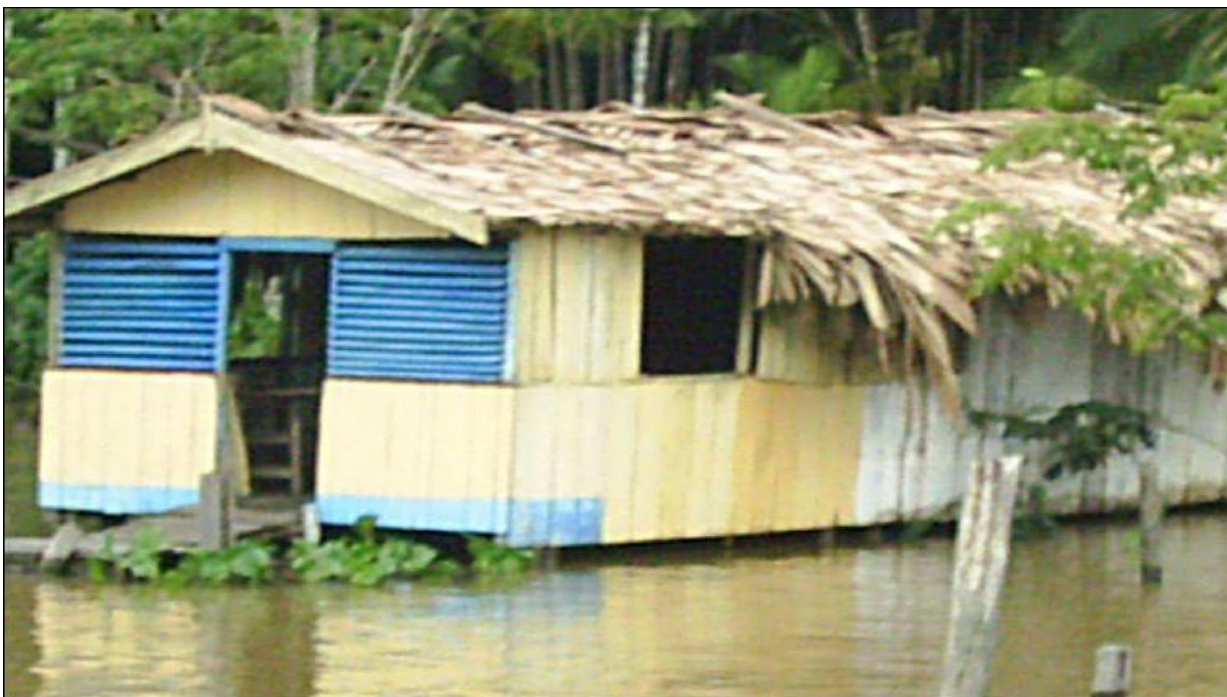
Fotografia 1: Escola da Rede Municipal de Ensino de Breves no meio rural ribeirinho, quase invadida pela cheia do rio. Fonte: Leão e Farias, 12/01/2007.
